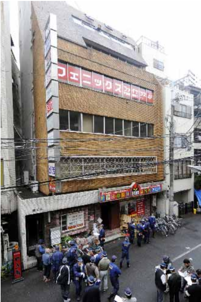
1階の個室ビデオ店から火災が発生、多数の死者が出た大阪・難波の雑居ビル = 1日午前7時54分
